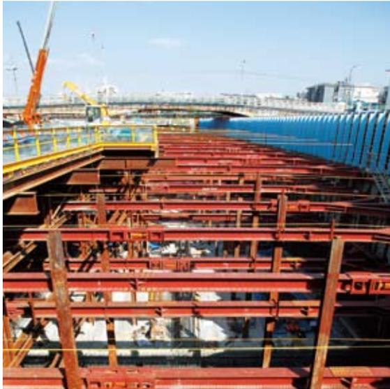
延長1886mの大規模な開削工事
